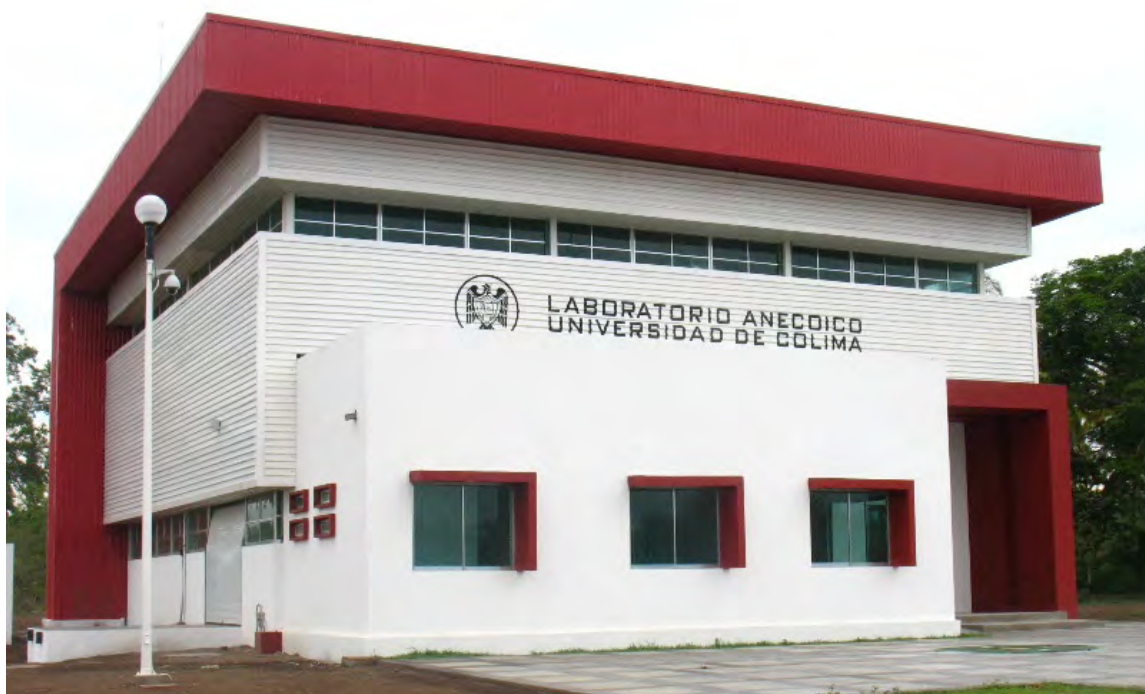
Construcción del Laboratorio Anecoico de Radio Frecuencia, Tecno-Parque. Colima, Colima. Fuente: Dirección General de Recursos Materiales. Informe de labores 2013.
